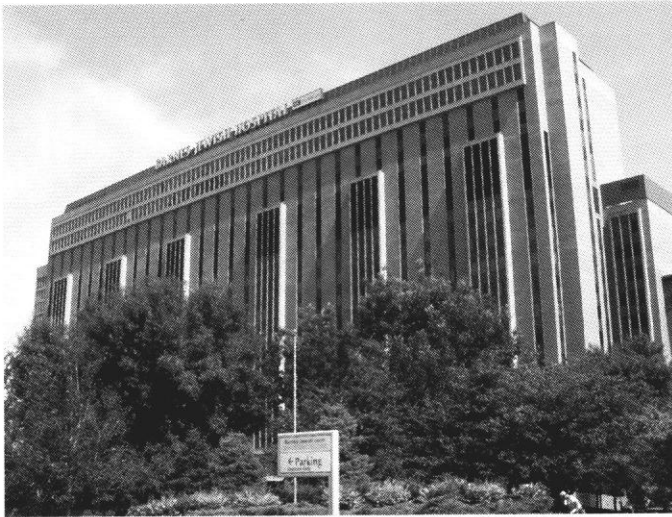
写真1 この Barnes Jewish Hospital South を始め、North, St. Louis Children's などの病院、その他様々な研究施設が集まって、広大な Medical Campus を形成している。
